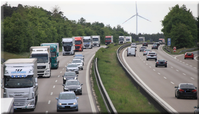
Im Landkreis Ansbach (wie hier bei Lichtenau) ist die Autobahn 6 größtenteils noch nicht sechsstreifig. Nun hat der Ausbau von Schwabach-West bis Triebendorf (Stadt Heilsbronn) begonnen.
